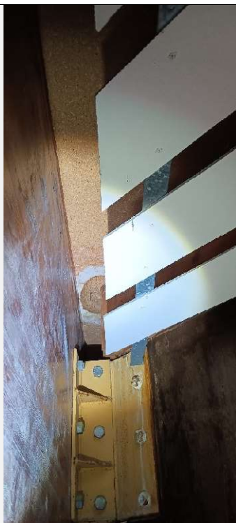
Photo 16 – Trace ancienne d'humidité sur le panneau bois en toiture.
