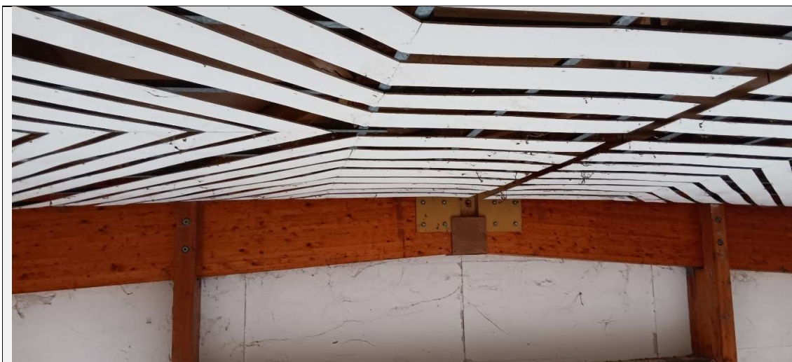
Photo 9 – Premier portique pignon est, avec les poteaux fixés en enfourchement et boulonnés.
