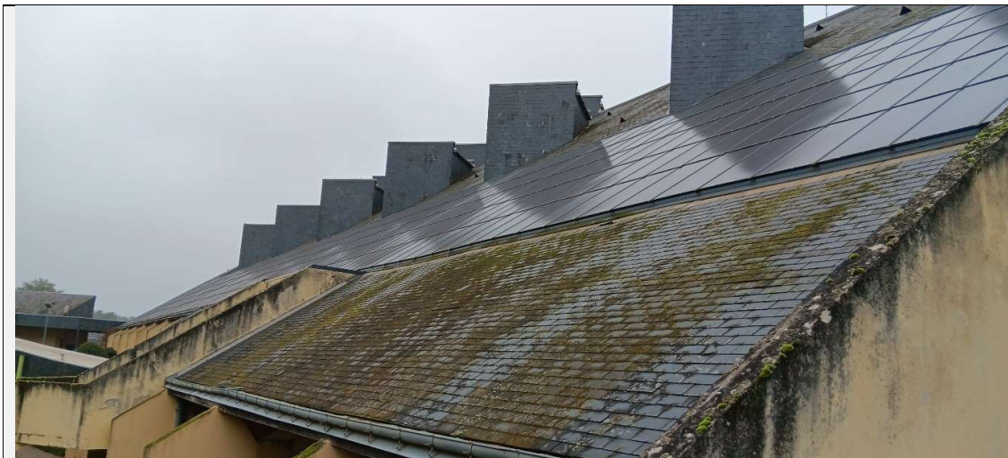
Photo 1 – Couverture avec panneaux photovoltaïques façade sud. Mousse sur ardoises. Légère déformée des la couverture entre deux arbalétriers. Puits de lumière dépassant en toiture, visibles, avec revêtement en ardoise sur les parois verticales.
