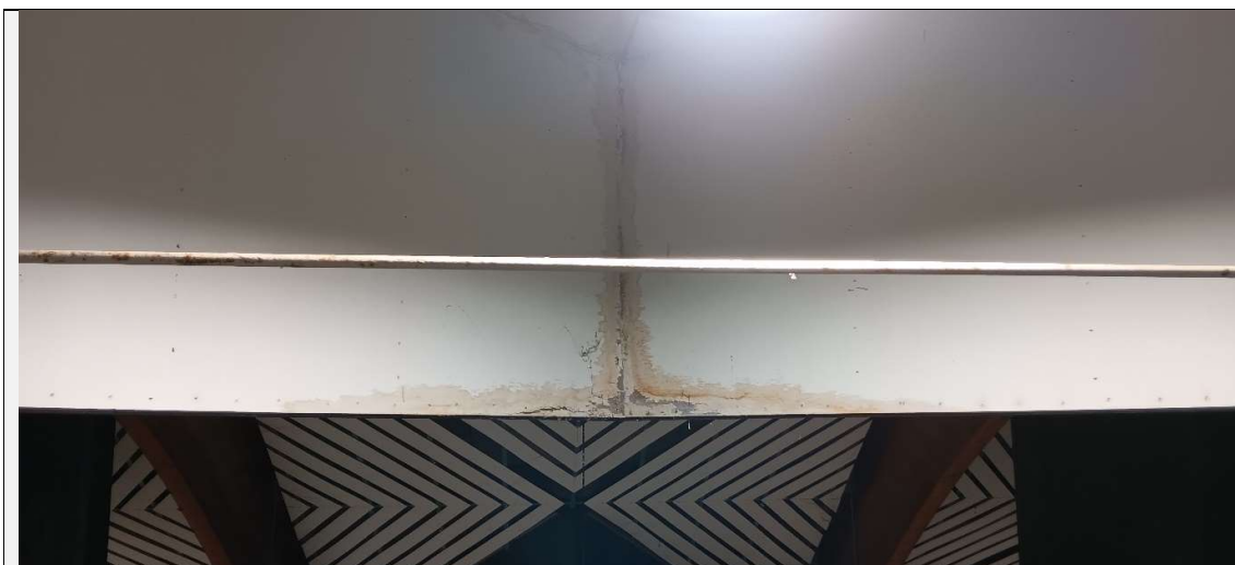
Photo 13 – Trace d'humidité sur les contreplaqués à l'intérieur des puits de lumière.
