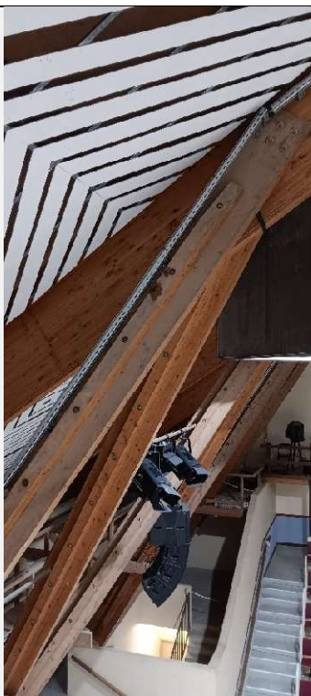
Photo 27 – Double jambe de force sous arbalétrier.
