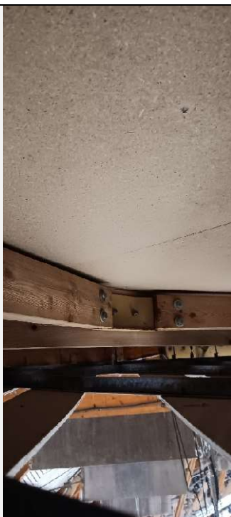
Photo 19 – Assemblage des contreventement en toiture par ferrure mécano soudé en âme.
