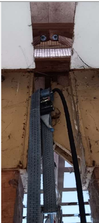
Photo 8 – ferrure du faitage, clef de faitage
