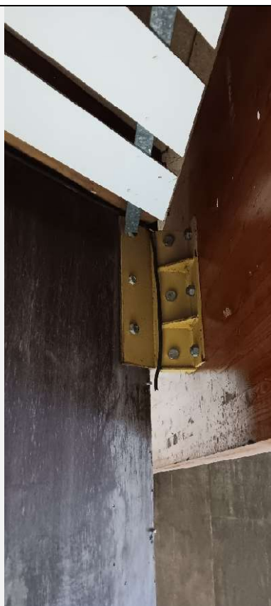
Photo 10 – Fixation d'un angle de puit de lumière sur l'arbalétrier via une ferrure mécano soudée.
