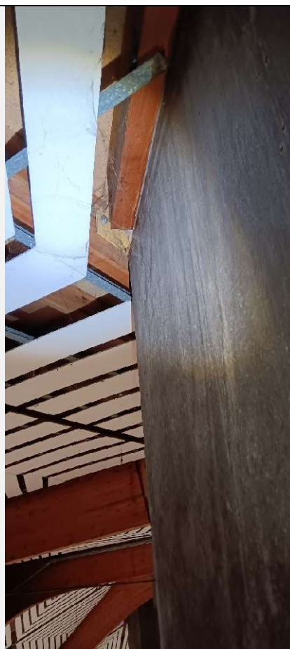
Photo 14 – Fixation des angles de puits de lumière aux pannes par des ferrures mécano soudées.
