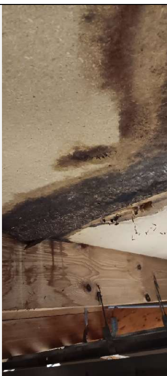
Photo 26 - Panneaux bois pourris en toiture, mais sec. L'intégrité de la capacité portante du panneaux affectée. Panneaux bois à remplacer.
