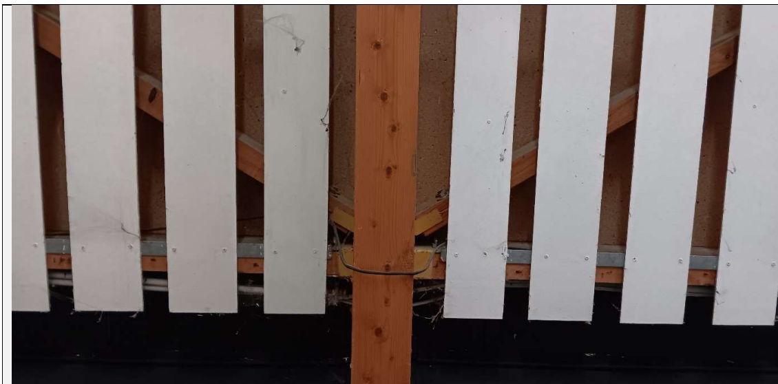
Photo 5 – En bas de pente de la façade pignon est, nous pouvons voir les pannes et les poutres de contreventement. Les pannes fixées sur sabot acier, et contreventement fixé sur ferrure en âme.
