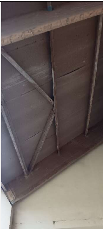
Photo 33 – Panneaux bois sous appentis légèrement déformés.
