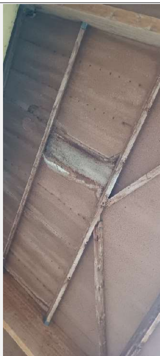
Photo 34 – Panneaux bois sous appentis avec trace de pourriture, à remplacer.
